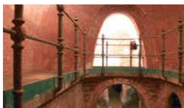
STOKA je vyrobena z hladkých cihel, má kluzký povrch, aby se na dně nezachytávaly odpadky, a je vystavěna v jedinečném vejčitém profilu. Foto: PVK
