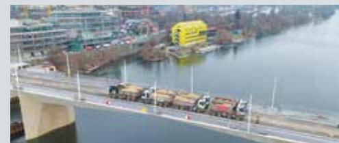
ZATĚŽOVACÍ zkouška dopadla na výbornou a otevření nové spojnice přes Vltavu již nic nebrání. Foto: MHMP
