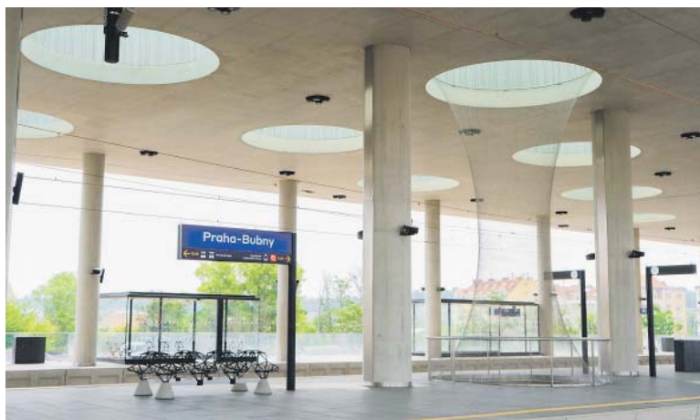
NOVÁ železniční stanice Praha–Bubny. Foto: SŽ
