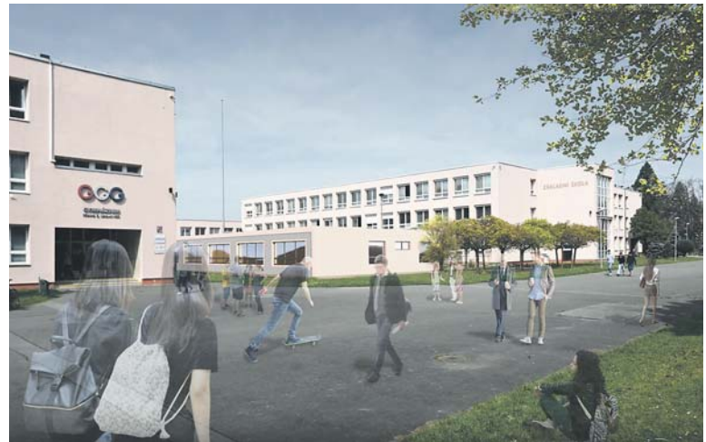
ŠKOLNÍ DRUŽINA je navržena jako jednopodlažní objekt s plochou střechou půdorysného tvaru L. Zdroj: MČ Praha 8
