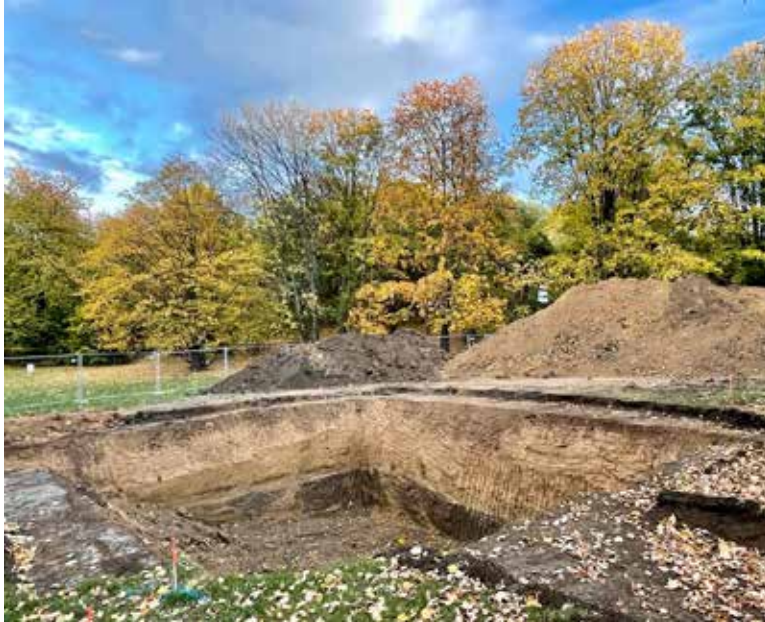
ZÁKLADY budoucí podzemní nádrže na dešťovou vodu. Foto: FCB
