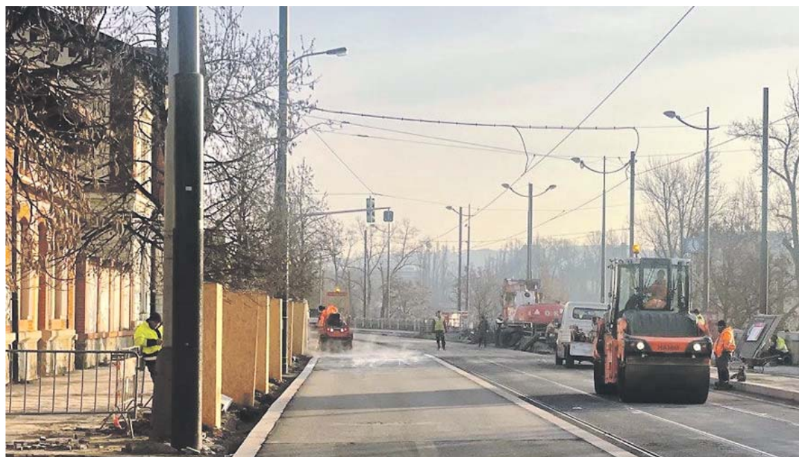
REKONSTRUKCE Bubenského nábřeží potrvá ještě dva měsíce. Zdroj: MČ Praha 7
