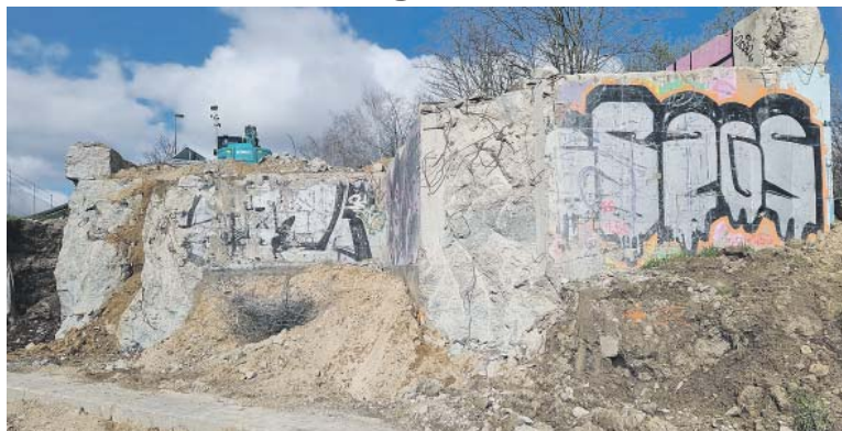
ZDE vyroste nový silniční most přes dálnici. Foto: TSK Praha
