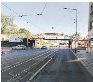
HISTORICKÝ železniční most byl přemístěn do sbírky Národního technického muzea. Foto: MČ Praha 7
