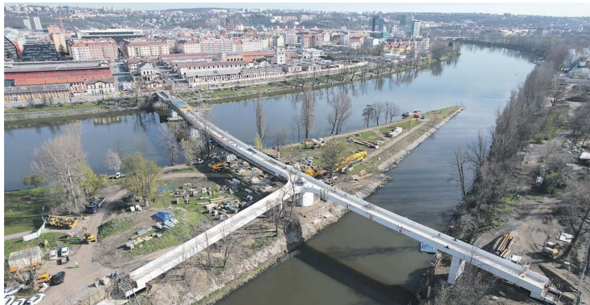
STAVBU štvanické lávky HolKa dokumentují také záběry z dronu. Zdroj: Skanska
