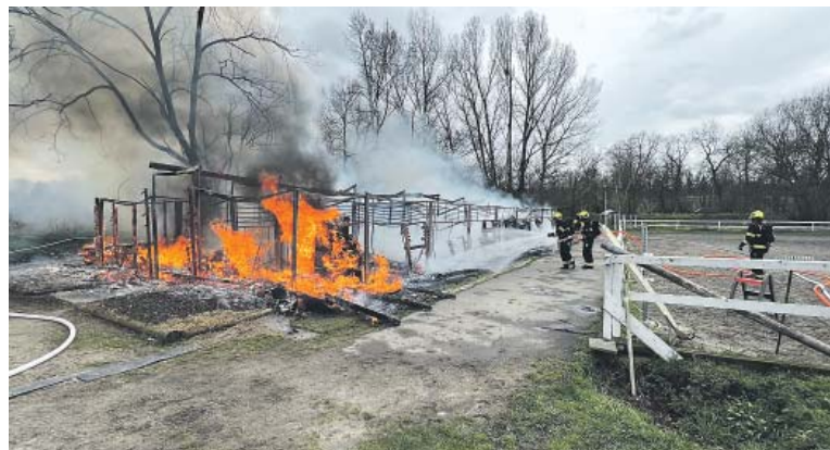
ZE STÁJÍ zbyly jen ohořelé základy. Foto: FCB Jezdecká škola
