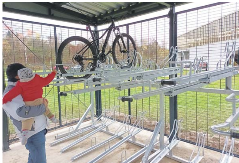
PŘÍSTŘEŠEK o půdorysu cca 5 x 5 metrů s možností dalšího rozšíření tvoří pozinkovaná ocelová konstrukce s obvodovým pláštěm z ocelových rámu i ocelovým výpletem a střechou z trapézového plechu vyspádovaným do dešťových žlabů. Foto: TSK Praha
