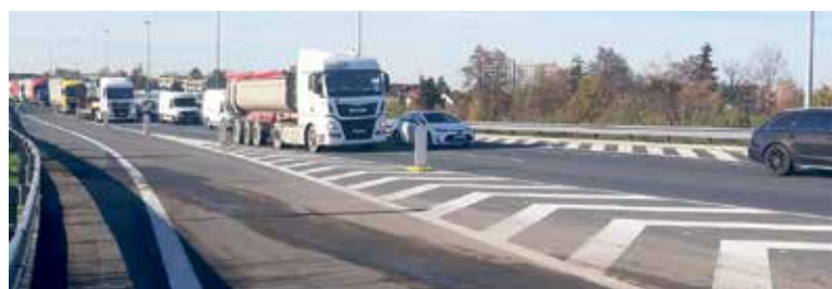
ODPOJOVACÍ rampa má charakter dočasného sjezdu do doby výstavby dalších částí Městského okruhu v této oblasti. Foto: TSK Praha
