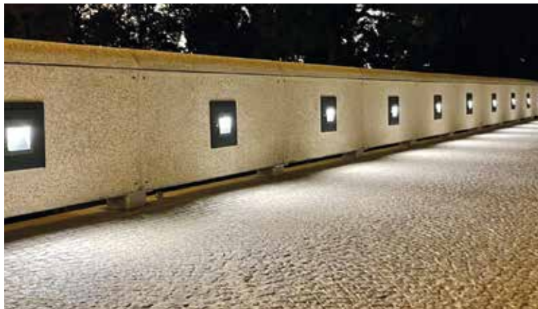
UKRYTÉ osvětlení, které přes 30 let nefungovalo, se opět rozzářilo. Foto: TSK Praha
