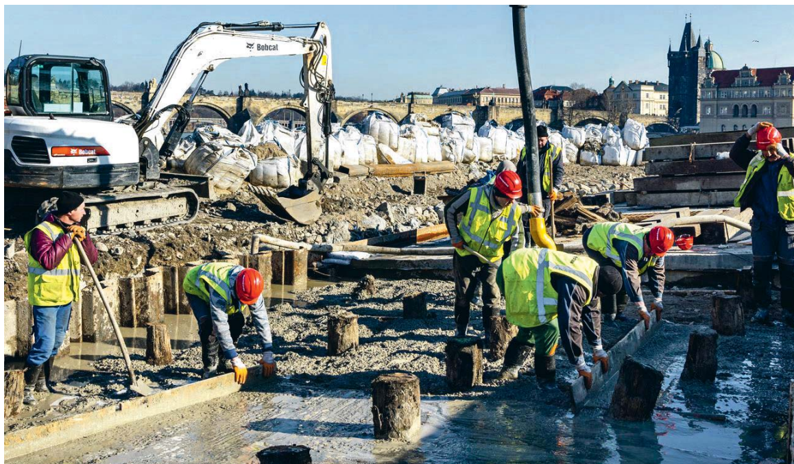
PRACOVNÍCI Metrostavu obnovují původní vzhled jezu včetně dubové konstrukce. Foto: Metrostav
