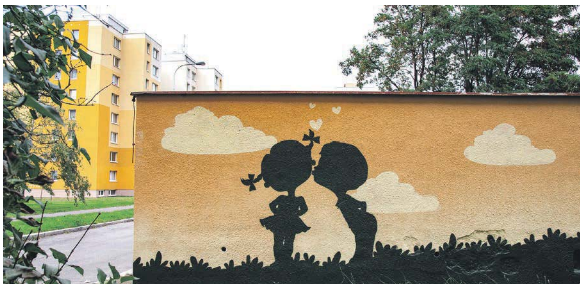
Teplo do jednotlivých domů přichází z výměňkové stanice, která přebírá dálkové teplo od teplárny. Tyto technické stavby nemusí být nudné, Pražská teplárenská pomalovala své výměňkové stanice pestrými barvami.
